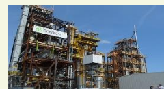
垃圾转化生物燃料大型设备
