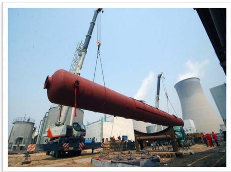
▶ 胜利油田电厂烟气捕集装置，年捕集能力4万吨。国内外首个燃煤电厂烟气CCUS全流程示范工程
