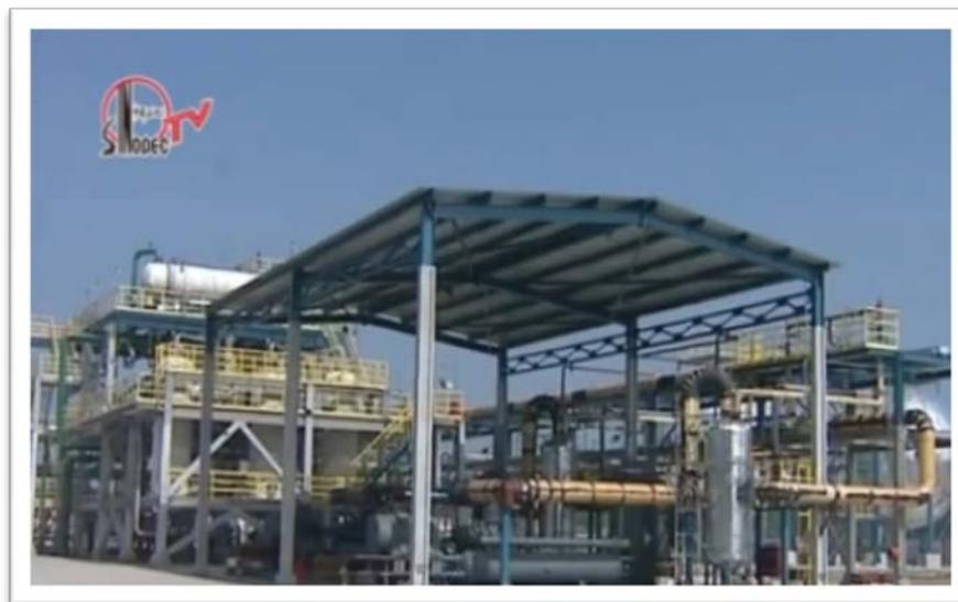
▶ 中原油田催化裂化装置烟气捕集装置，年捕集能力10万吨
